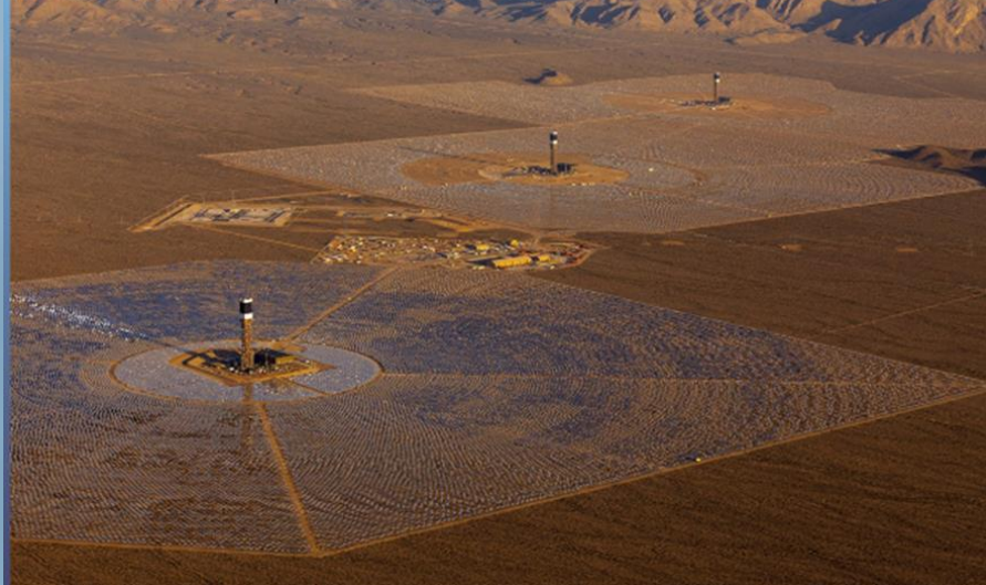
Cea mai mare centrală solară din lume Ivanpah , California - cca. 400 MW, furnizând electricitate pentru 140.000 de case
